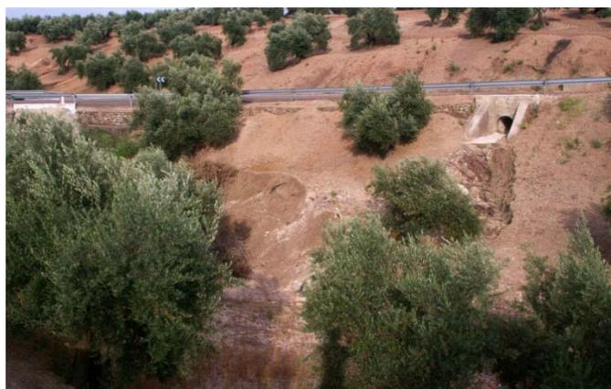
Fotografía3: Un par de canalizaciones para la circulación de aguas tras las tormentas en una carretera secundaria en Jaén causan una tremenda erosión generando pérdidas económicas y ecológicas a los propietarios sin posible solución salvo que se tomen medidas excepcionales. La consideración de AIEs junto a las carretas podría facilitar la restauración en estas zonas pro ejemplo podrían aunar beneficios económicos y ecológicos. Fotografía de Mario Fernández Barreda.
