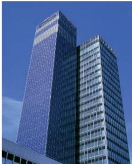
Figura 5. Edificio fotovoltaico. La fachada del edificio está formada por paneles solares.
