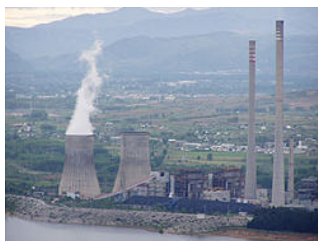
Foto 1. Central térmica de Compostilla en León
