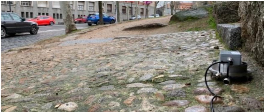
Figura 24: Colocación acelerómetro en la Calle Cañuelos.
