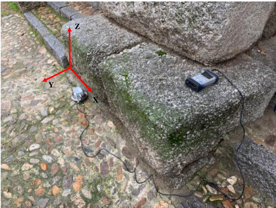
Figura 27: Posición de los ejes de medida en el Acueducto.
