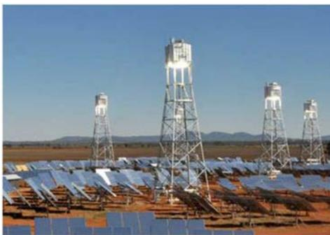
Figura 1. 5 Foto de la planta de Lake Cargellio en Australia primera de su clase con receptores de grafito. [21]
