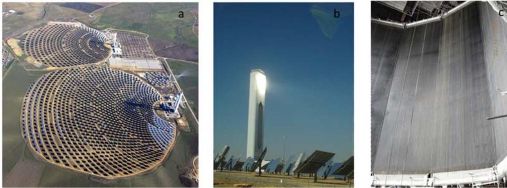
Figura 1. 2 a) Vista aérea de las centrales PS 10 y PS 20. b) Imagen de la torre de PS10 c) Receptor PS20 alojado en la cavidad durante su construcción
