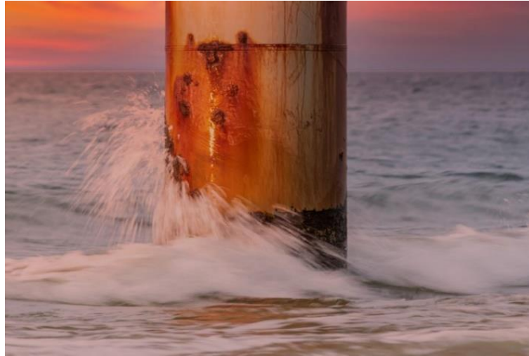
Figura 1.7 Superficie corrosiva de una estructura "offshore" marítima.
