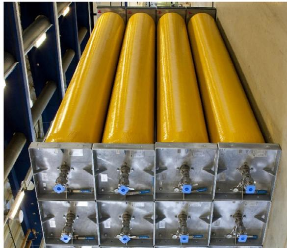
*Figura 9. Buffer de hidrogeno [21]*
