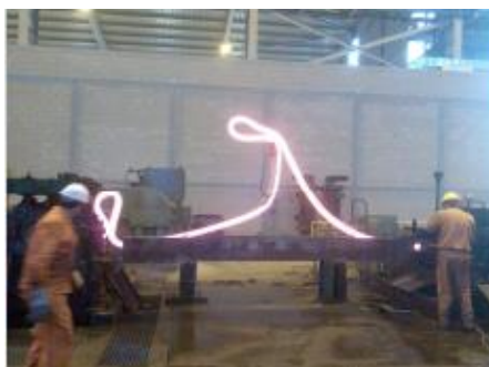
Figura 20. Ejemplo fallo en el sistema de control del tren de laminación
