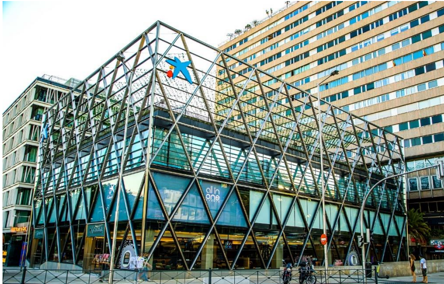
Ilustración 5: Nuevas oficinas all in one CaixaBank. Fuente: CaixaBank.
