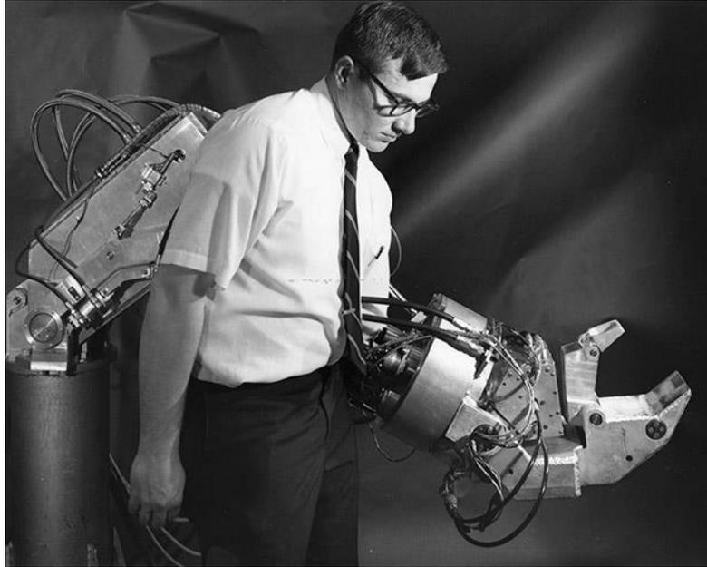
*Figura 10. Exoesqueleto Hardiman. Fuente: Fick B et al. (191)*
