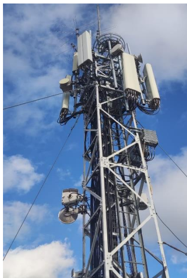
Figura 42. Instalación de sistema radiante.
