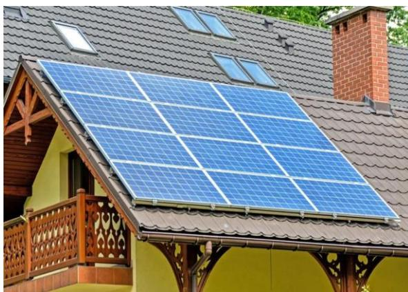
Figura 16. Estructura coplanar sobre tejado.
