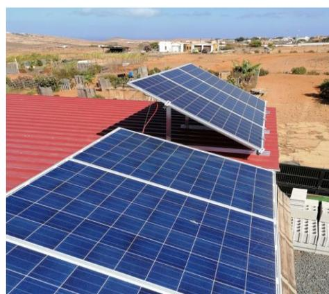
Figura 17. Paneles en posición libre sobre tejado.
