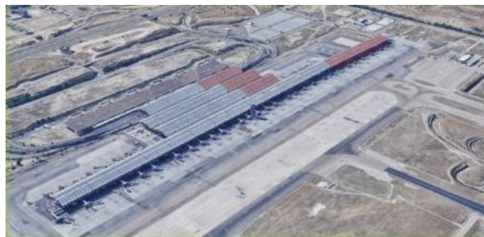
Figura 7: Ampliación de las terminal T4.
