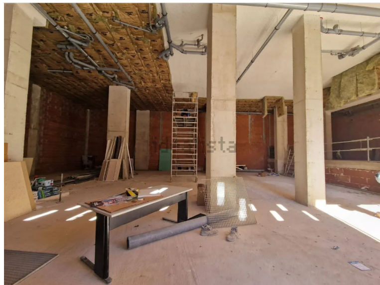
Figura 5.2: Interior actual del establecimiento.
