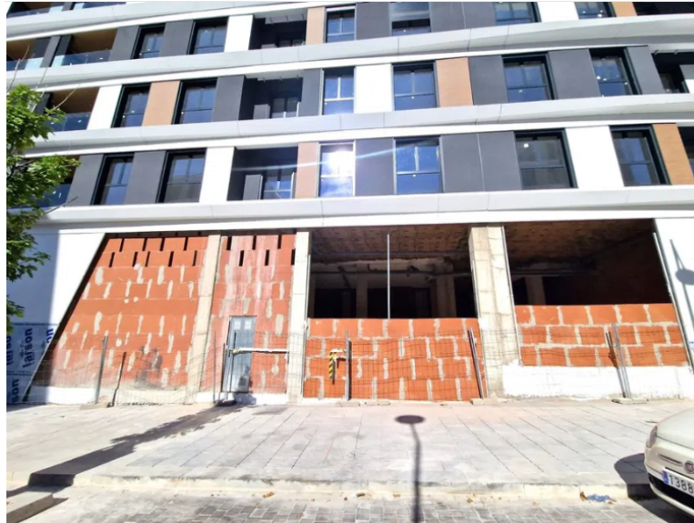
Figura 5.1: Fachada actual del establecimiento.
