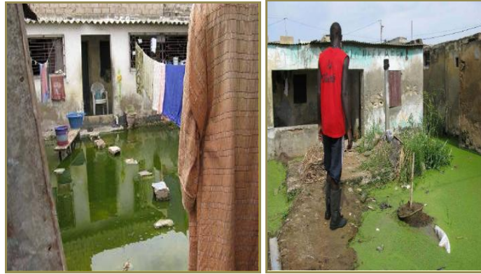
Fig. 3.3. (izda) Una casa inundada en Guinaw-Rails. Fig. 3.4 (dcha). Recuperación de otra casa abandonada.
