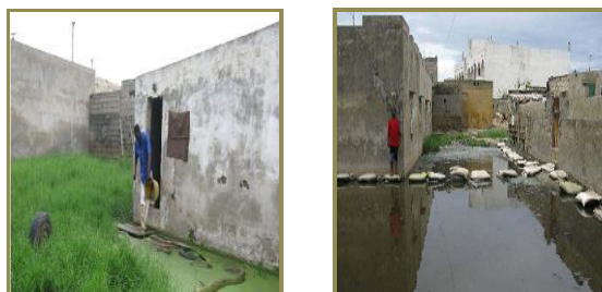
Fig. 3.6. (izda) Un hombre vacía su casa con un balde. Fig.3.7. (dcha) Vecinos usan sacos de arena como puentes. Fuente: ATD Quart Monde
