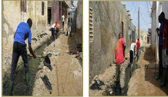
Fig. 3.8 (izda) y Fig. 3.9 (dcha). Trabajos de mantenimiento de un canal.
