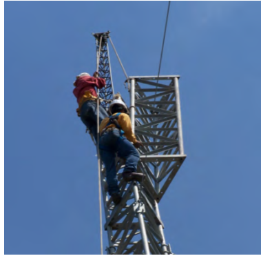
Figura 16.2.: Instalación de un tramo de torre.
