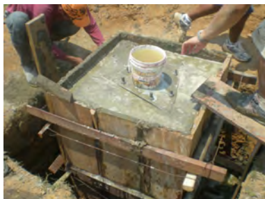
Figura 16.1.: Instalación de una base de torre.
