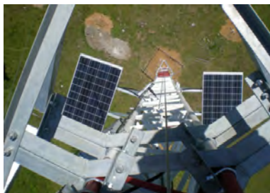
Figura 16.10.: Fijación de paneles fotovoltaicos izados en la torre.
