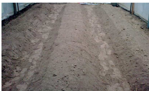
Figura 7.3: Construcción de las camas
