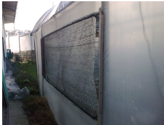
Figura 2.5: Ventana lateral del invernadero (Sistema de ventilación)
