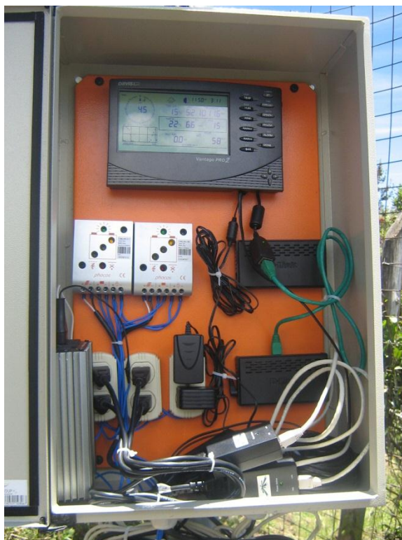
Figura 3.5.3. Fotografía de tablero montado
