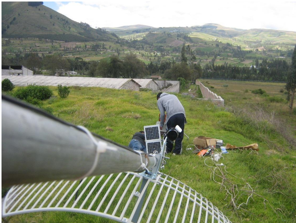
Instalación de estación meteorológica
