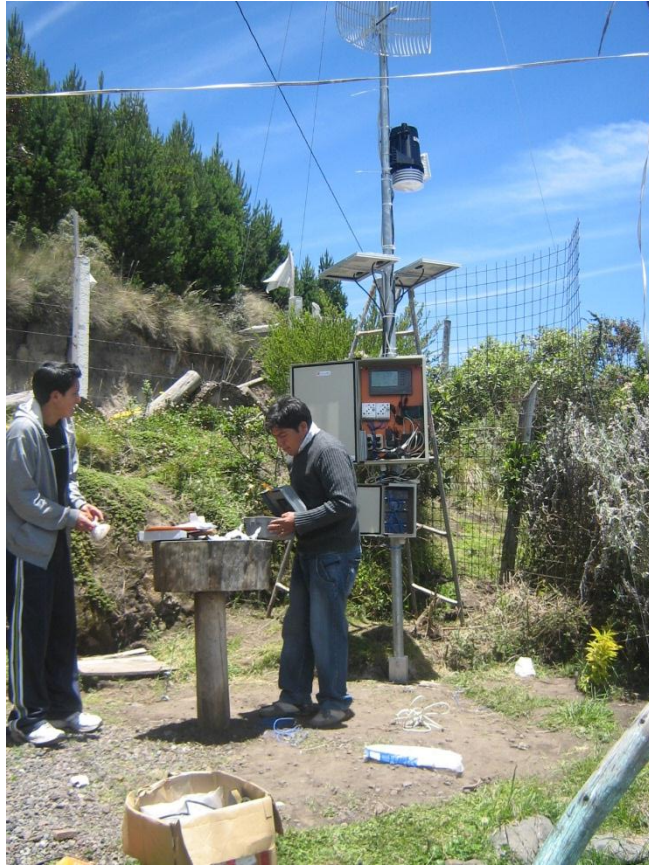
Instalación de estación meteorológica
