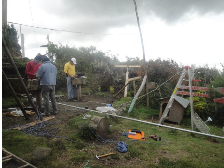
Figura 3.5.6. Implementación de la torre En las siguientes imágenes se observan cada uno de los emplazamientos instalados y en operación.
