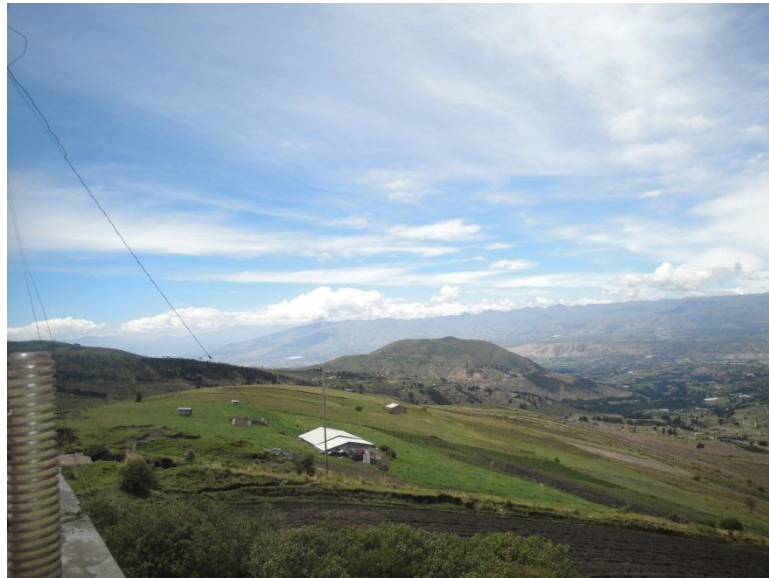
Figura 3.2.4. Central Hidroeléctrica Illuchi 1
