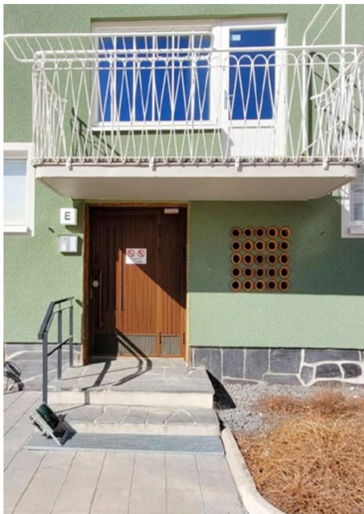
Figura 8. Detalle de las terrazas que parten de los rellanos de las escaleras. En la barandilla se observan los tendedores para secar la ropa y para airear edredones y alfombras. Fuente: Cortesía Rosana Rubio Hernández.
