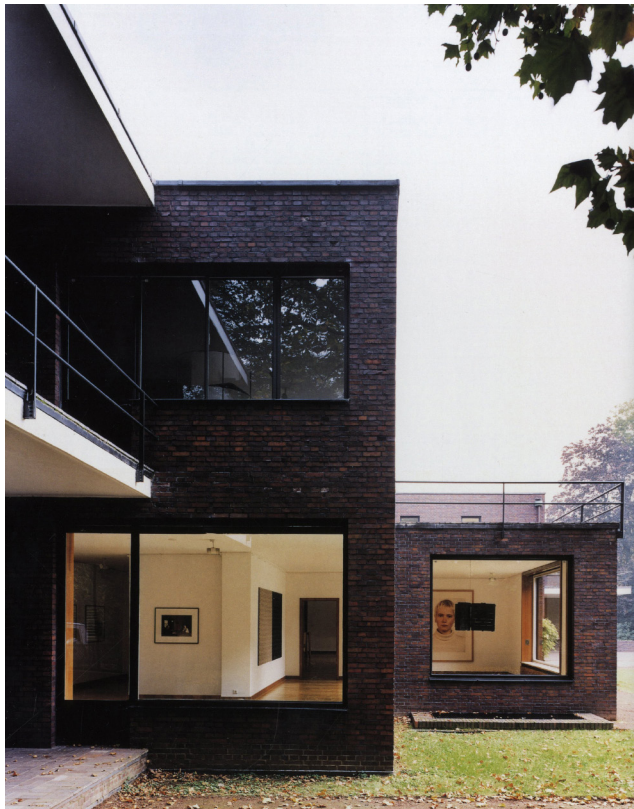
Fig. 03. Mies Van der Rohe. Vista de la Casa Lange, Krefeld, 1927-1930.
