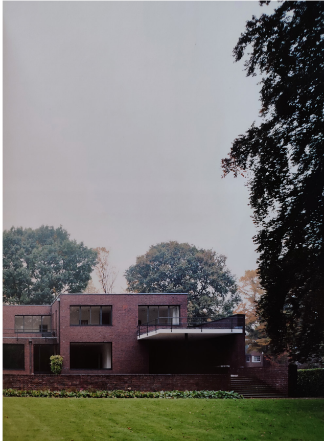
Fig. 02. Mies Van der Rohe. Vista de la Casa Lange, Krefeld, 1927-1930.
